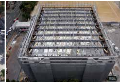
屋根鉄骨工事施工状況
