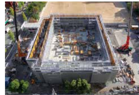
躯体工事施工状況
